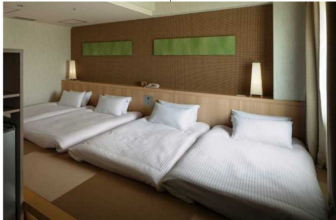
枕元幕板（米松30×240）+枕元灯 補修面クロス張替
