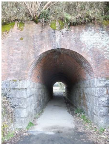
大仏鉄道遺構梶ヶ谷隧道
