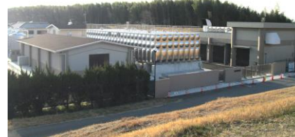
宮ノ裏浄水場
