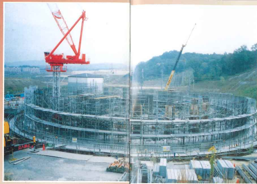
③躯体工事
