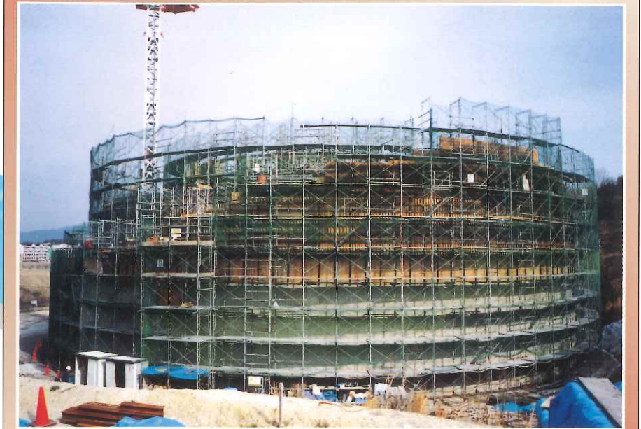
④躯体工事
