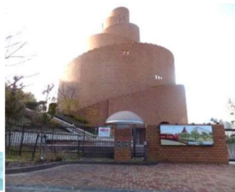
タツタタワー木津川市
