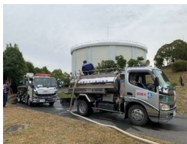
奈良市平城西配水池での注水
