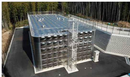
山城配水池 南部配水区域 (平成29年度建設、容量1,700 \text{m}^3 )
