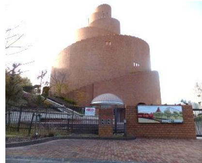
タツタタワー-木津川市
