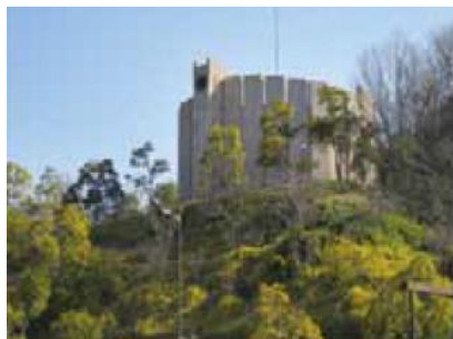
木津川台配水池 有効容量 2,068㎡×1池
