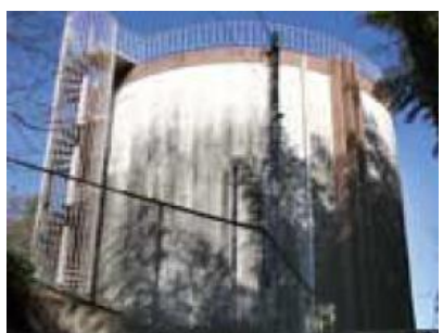
南加茂台配水池 有効容量高区 514.5㎡×1池 低区 600.0㎡×2池
