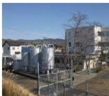
山城浄水場 施設能力4,000㎡/日
