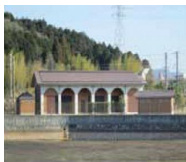
木津受水場 施設能力6,000㎡/日
