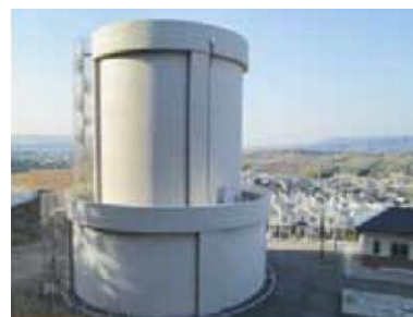
木津東配水池 有効容量高区 408㎡×1池 低区 1,243㎡×1池
