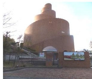
タツタタワー木津川市
