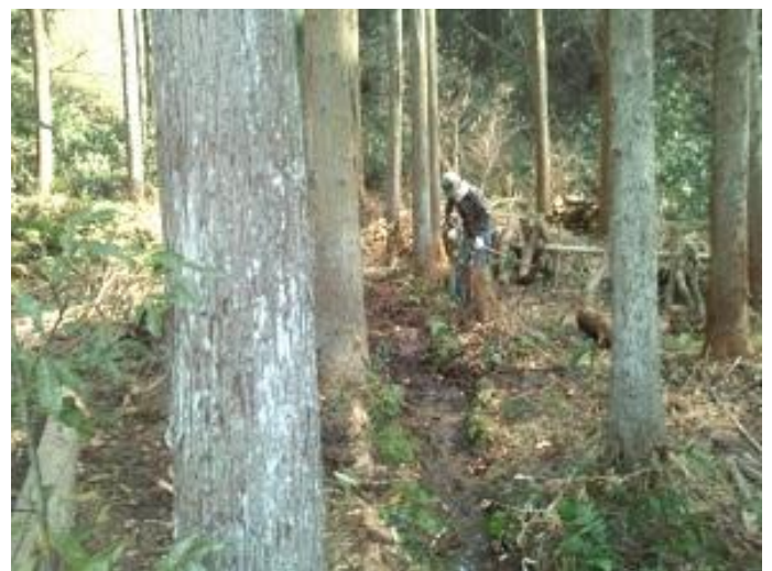
水はけを良くするための水路も完成
