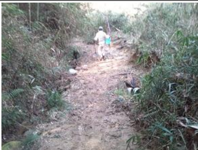
進入路を横断していた水路には土管を敷設
