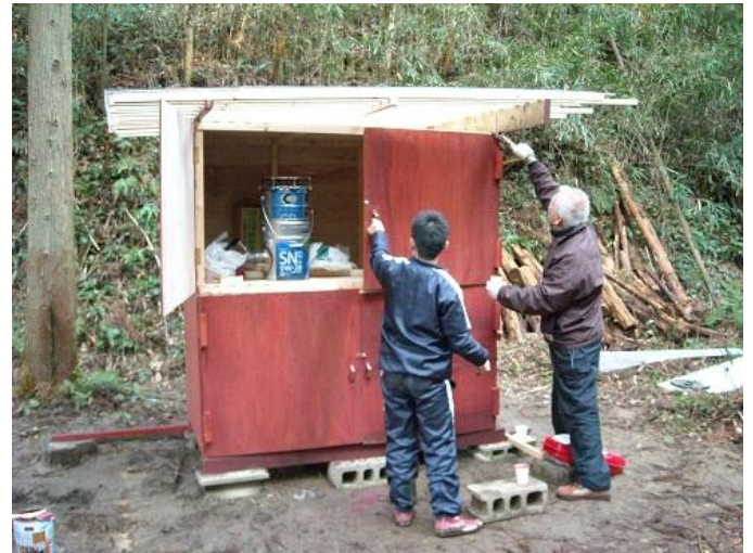
道具箱も防腐剤処理
