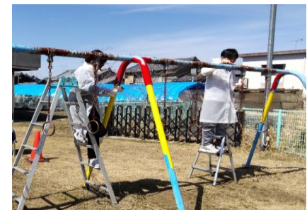
＜上粕小学校遊具の塗装＞
