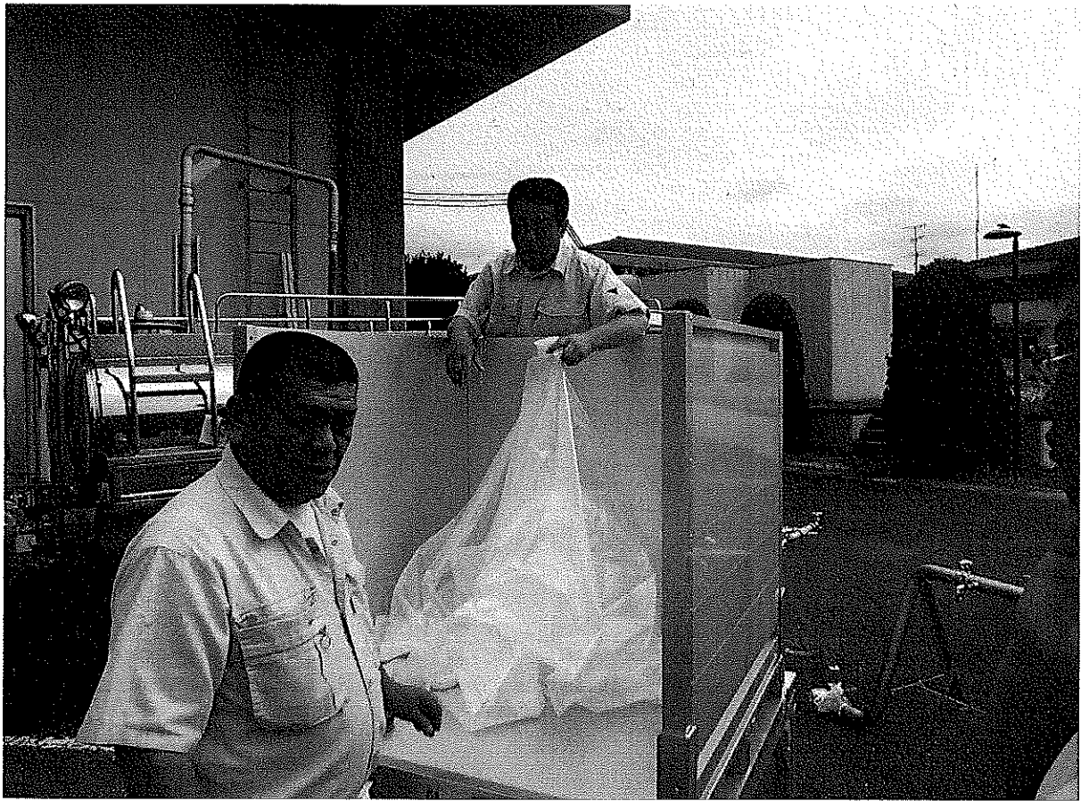
仮設給水タンクの組立③
