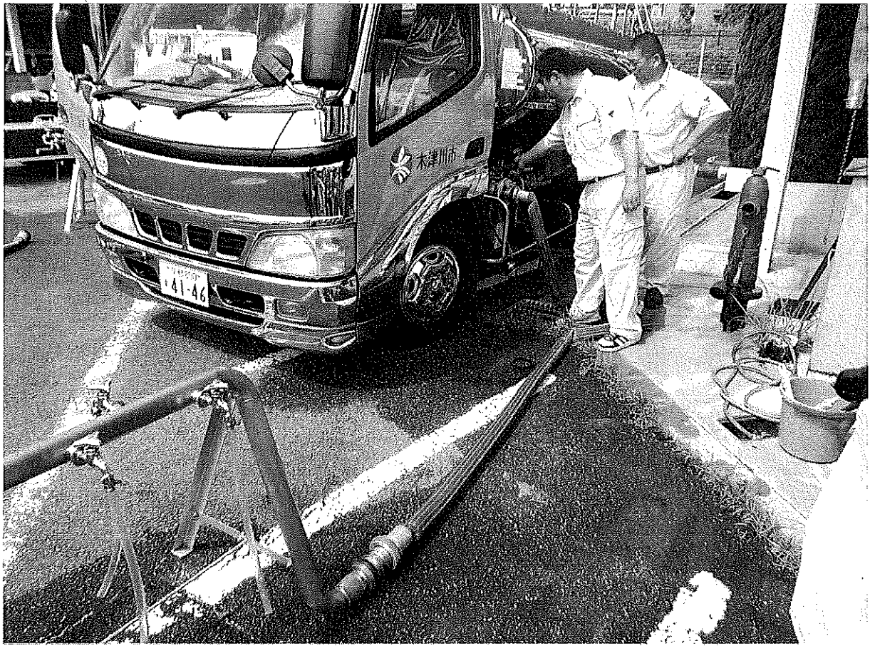
給水車と応急給水栓を接続
