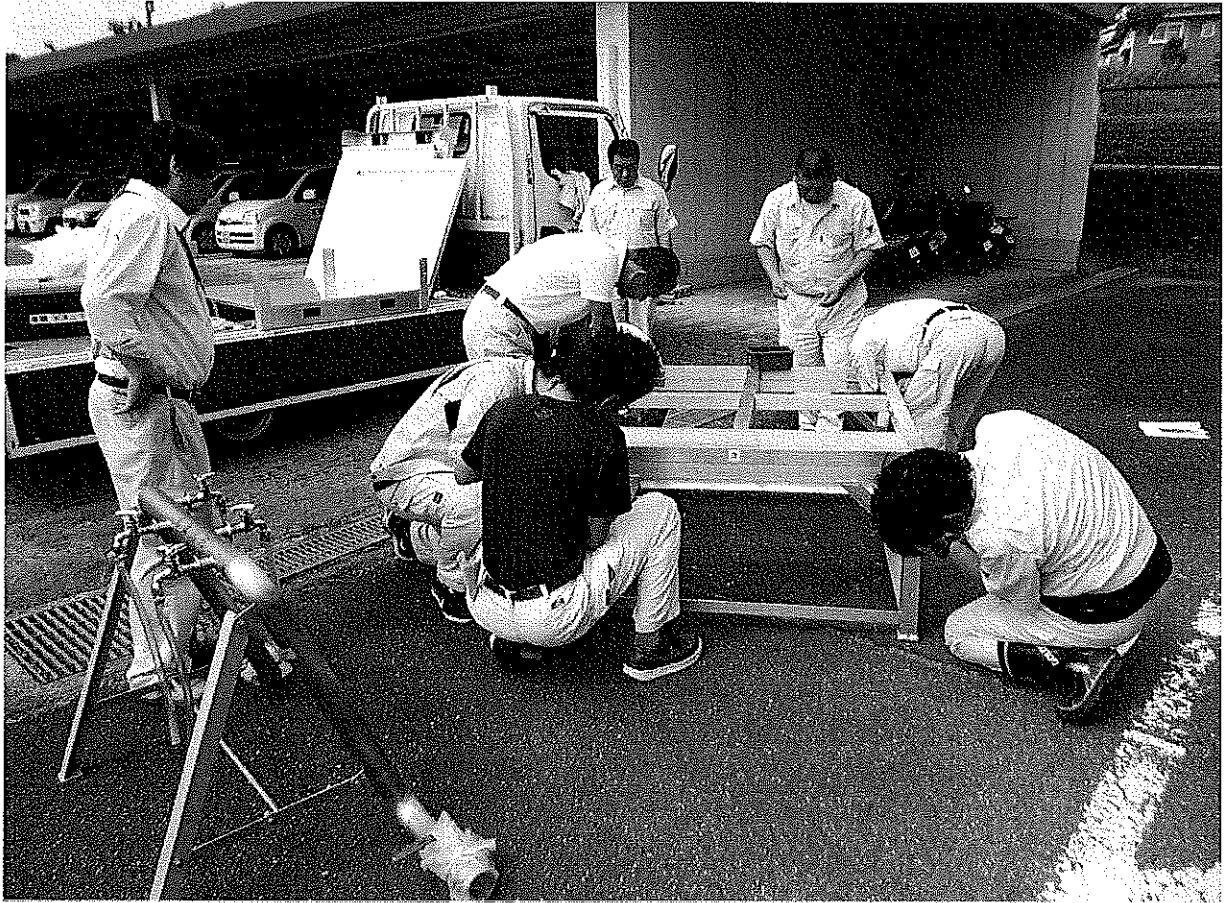
仮設給水タンクの組立①
