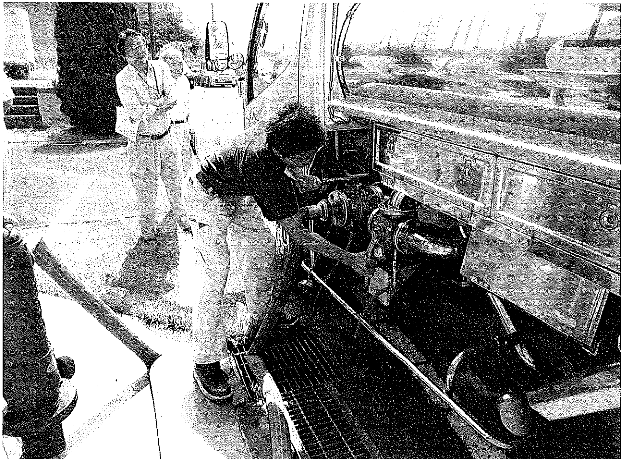
消火栓から給水車へ注水
