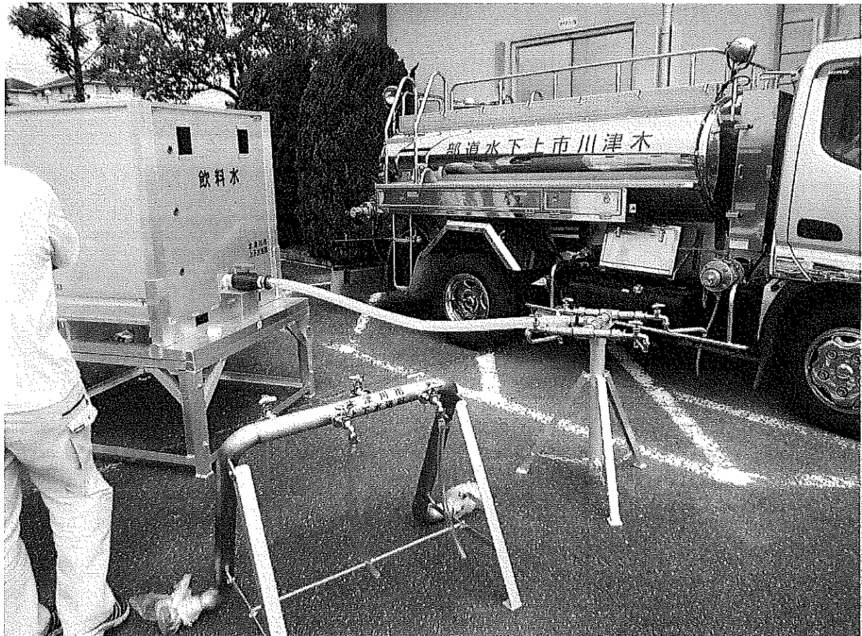
仮設給水タンクと応急給水栓を接続
