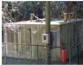
尻枝配水池 有効容量 28㎡×2池
