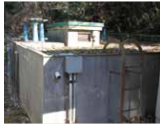
岩船配水池 有効容量 36.0㎡×2池
