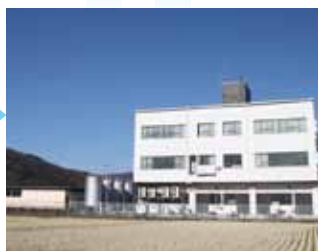
観音寺浄水場 施設能力5,400㎡/日
