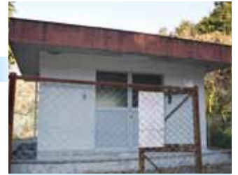
勝風配水池 有効容量 19.1㎡×2池
