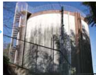
南加茂台配水池 有効容量高区 514.5㎡×1池 低区 600.0㎡×2池
