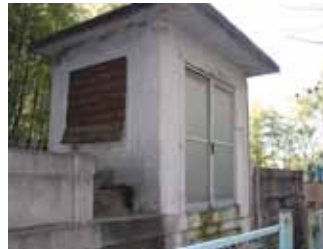
里配水池 有効容量 82.8㎡×2池 73.1㎡×2池
