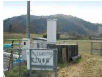
河原取水井 φ0.35m×深度98m 尻江取水井 φ0.35m×深度115m
