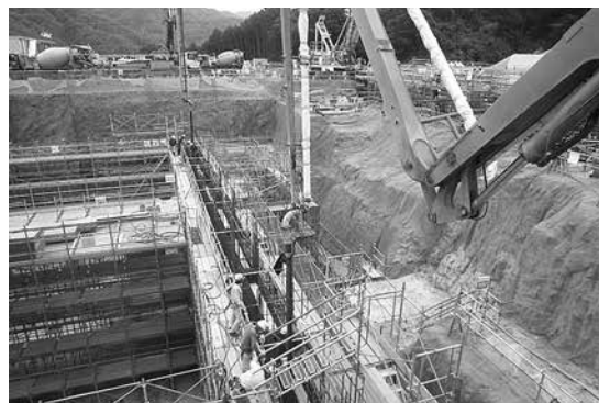
【炉室・機械室 コンクリート打設の様子】
