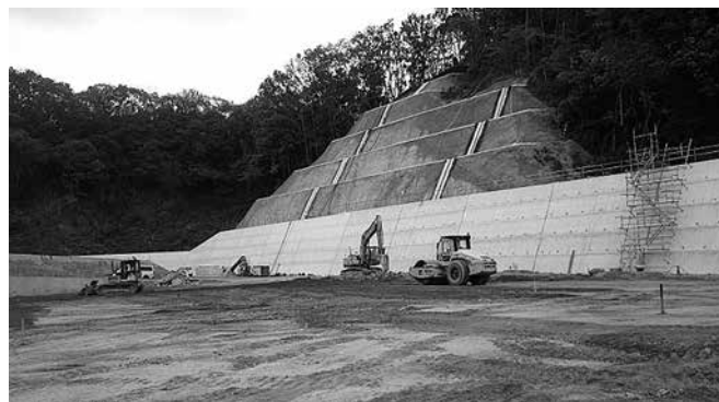
クリーンセンター建設予定地の整備状況
