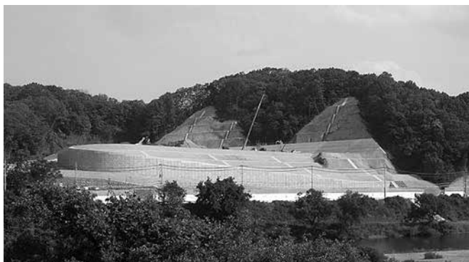
木津川対岸にある国道163号からの現場状況
