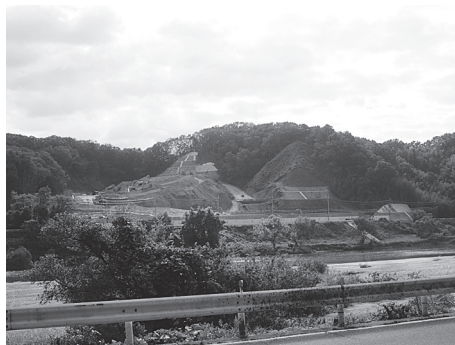
木津川対岸にある国道163号からの現場状況
