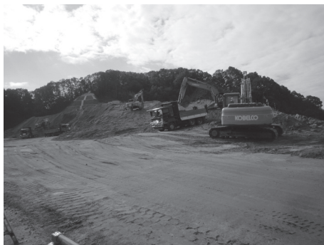
新たなクリーンセンターが建設される平坦地の整備状況
