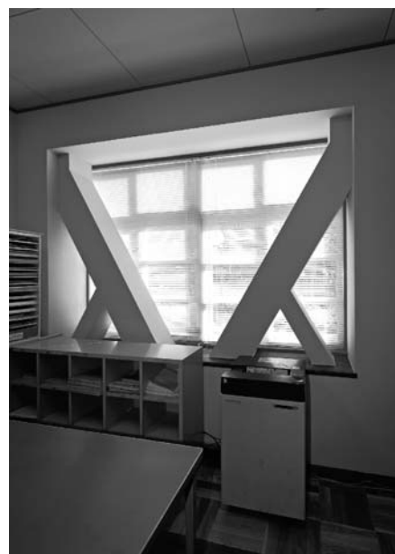
上狛小学校南校舎の耐震補強
