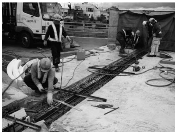
姫子橋の伸縮装置取替工事
