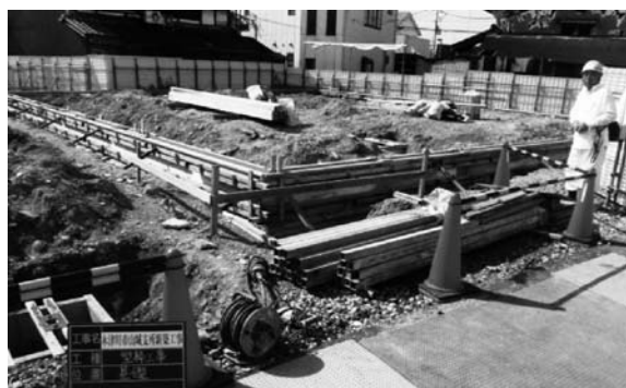
山城支所庁舎建設工事
