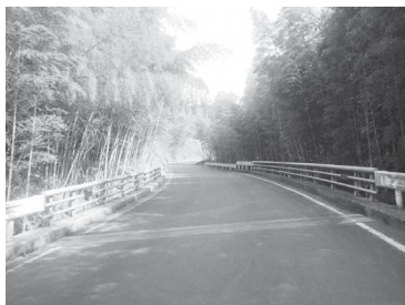
舗装打替など補修工事を行う車谷1号橋
