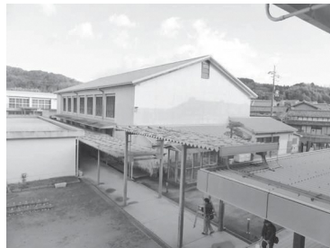
安全確保のため解体する旧加茂体育館
