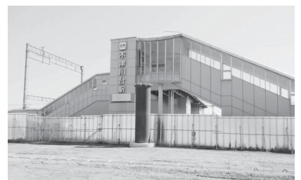
木津川台駅前線整備工事のようす
