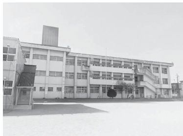
解体工事を行う木津小学校北校舎
