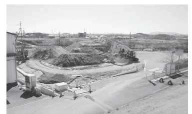
小川地内の排水ポンプ施設新設工事のようす
