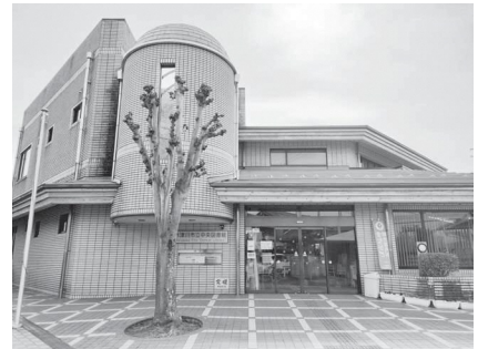
長寿命化改修を行う中央図書館
