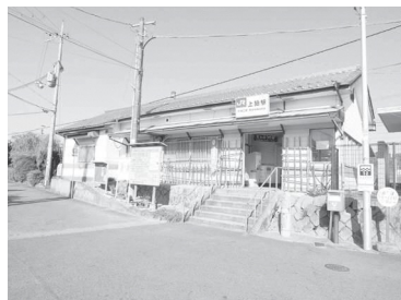
スロープ設置工事を行うJ R上狛駅
