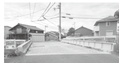
補修工事を実施した大正橋
