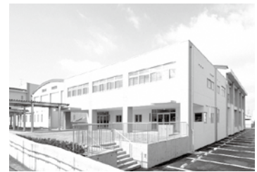
新築した城山台小学校第2体育館
