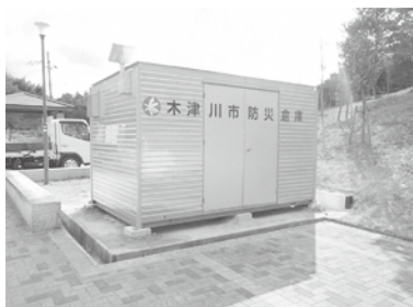
城山台公園に設置した防災倉庫
