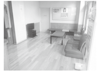
床を改修したやすらぎの湯のホール
