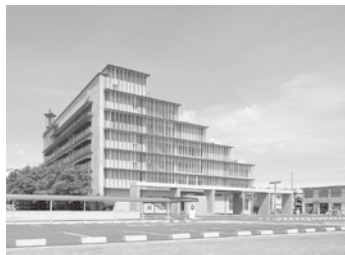
外壁等改修工事を行った本庁舎
