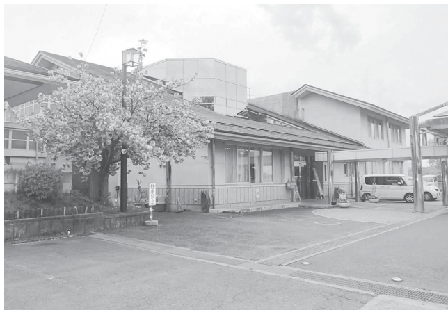
防水等の改修を行う山城保健センター・やすらぎコミュニティセンター
