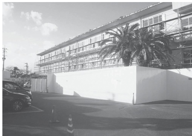
新校舎建築予定地で解体工事中の木津小学校南校舎
