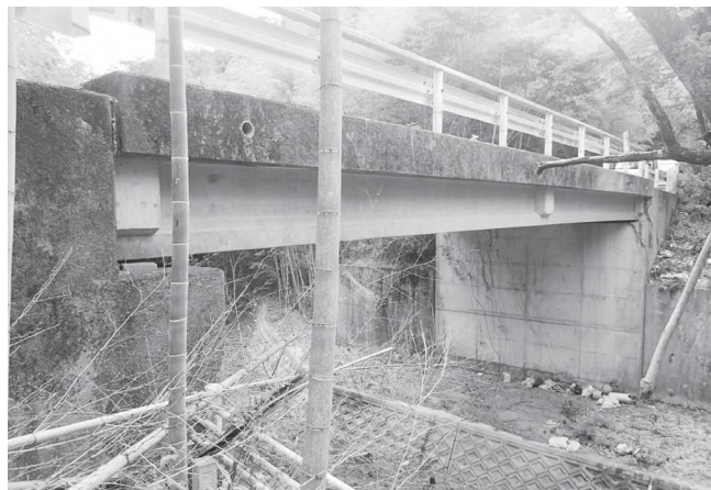
補修を行う農道橋りょう
