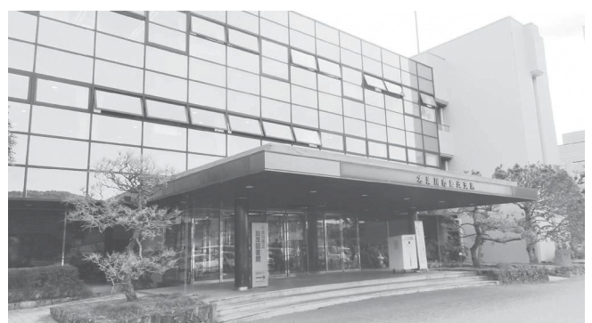
消火設備などの改修を行う加茂支所
