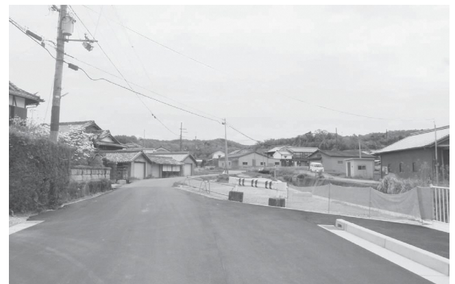
木津中ノ川線道路改良予定箇所
