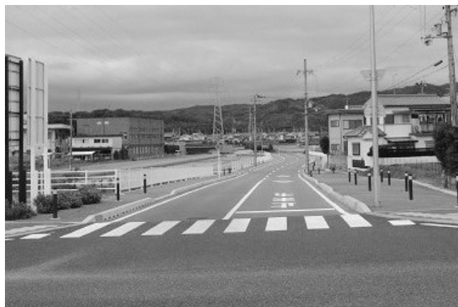
完成した内垣外内田山線
