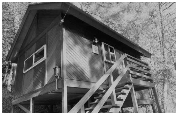
リノベーション工事が完了した山城町森林公園の宿泊施設
