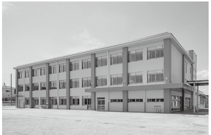
完成した城山台小学校ふたば学舎
