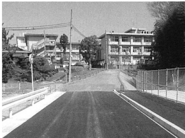
整備中の木津内田山線
