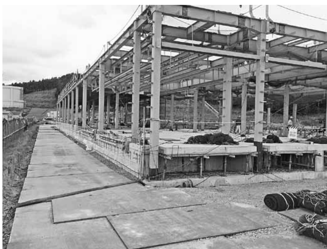
(仮称) 新学校給食センター建設の様子
