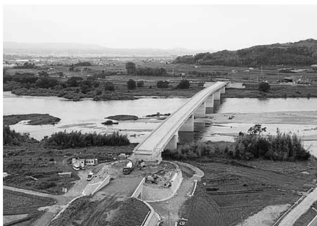
東中央線木津川架橋
