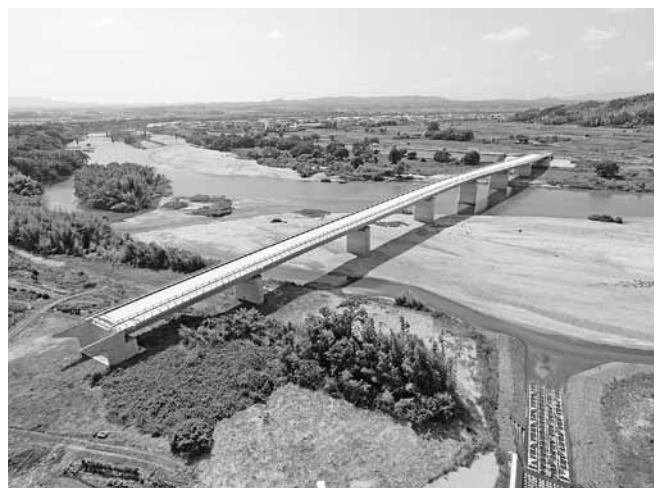
東中央線木津川架橋
