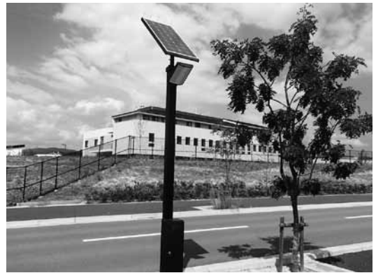
新しく設置された避難施設誘導灯
