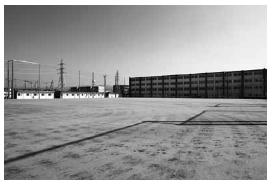
整備が完了した木津中学校
