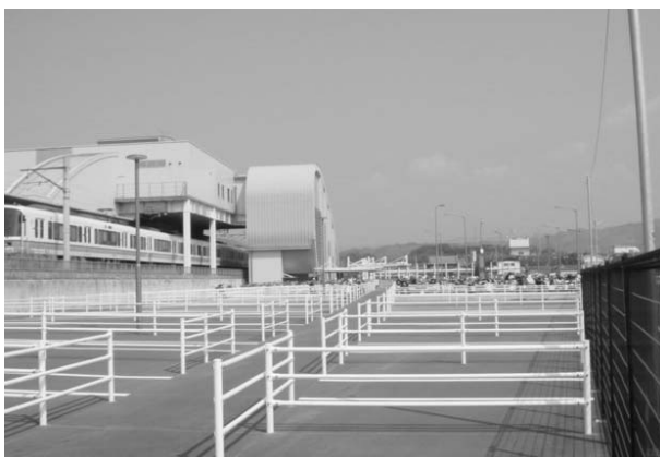
木津駅東側駐輪場
