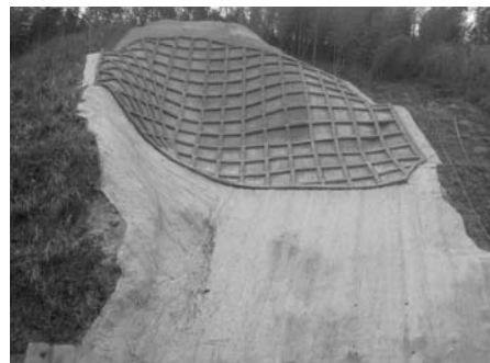
農免農道の災害復旧(山城町綺田地区)
