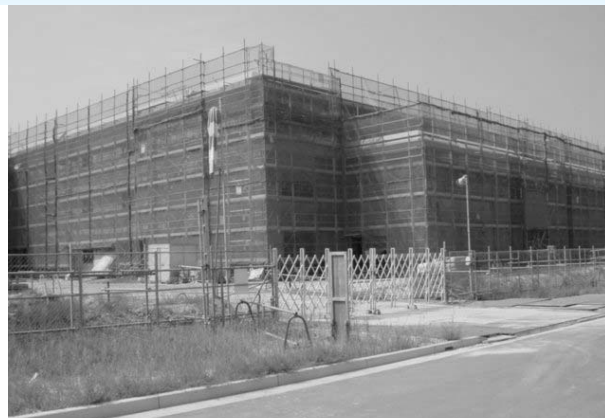
(仮称)城山台小学校の建設
