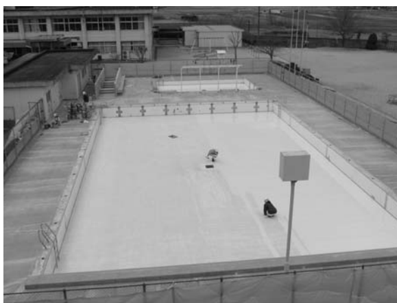
加茂小学校プールの改修
