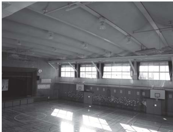
相楽小学校体育館の耐震補強
