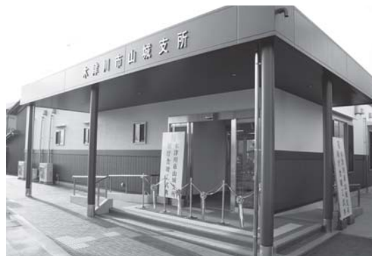
新しい山城支所庁舎
