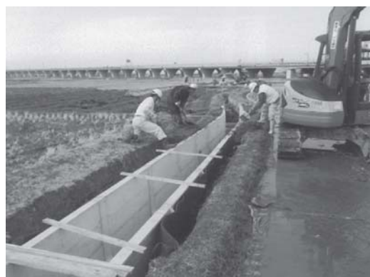
小釜川改修工事
