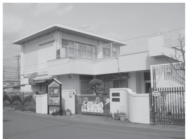
耐震補強を行う清水保育園
