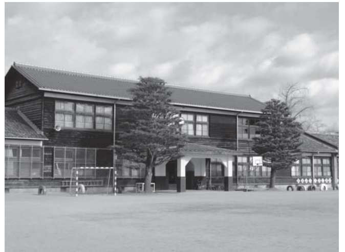
耐震診断を行う恭仁小学校校舎
