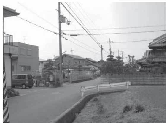
道路整備を行う山城町上粕的場地区
