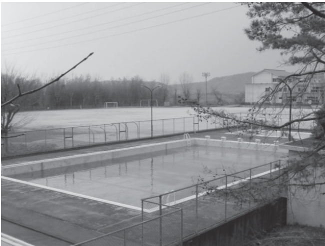
改修工事を行う南加茂台小学校プール
