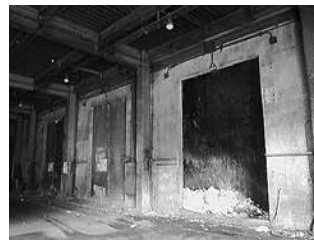
ごみを投入する プラットフォーム
