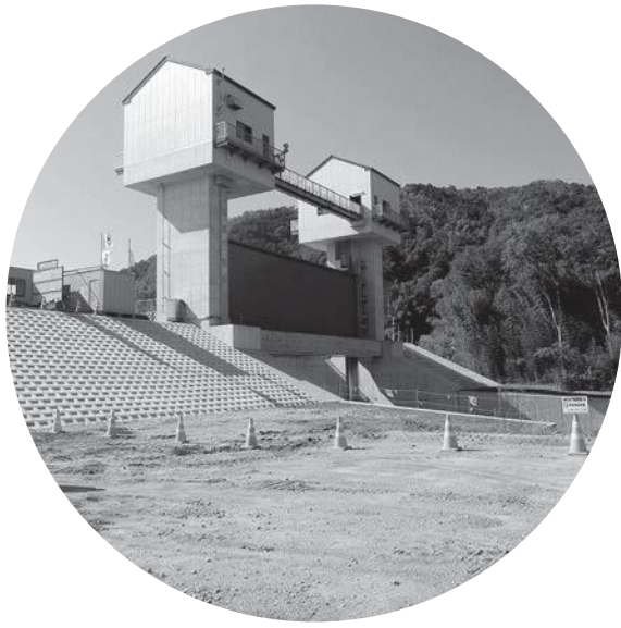
浸水被害の軽減に期待 (赤田川水門)
