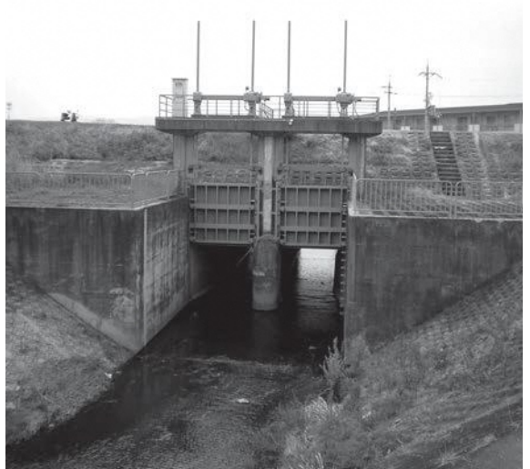
二ツ樋排水樋門の能力向上へ
