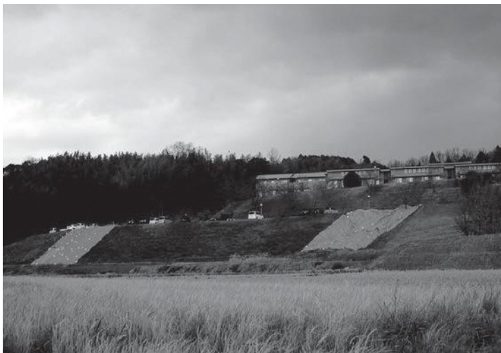
台風21号により崩壊した山城ぬくもりの里のり面 (市有地)
