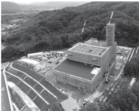
完成間近の環境の森センター・きづがわ
