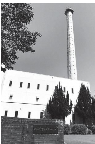
37年間稼働の打越台環境センター
