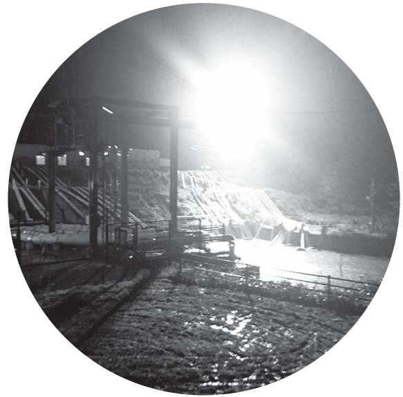
懸命な排水作業（木津合同樋門）
