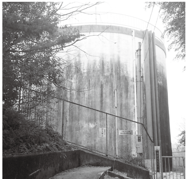
南加茂台給水タンク
