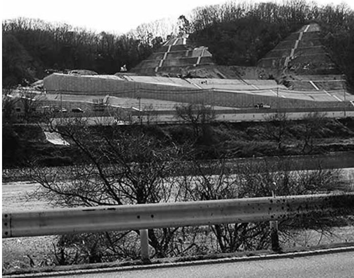
施設の建設始まる
