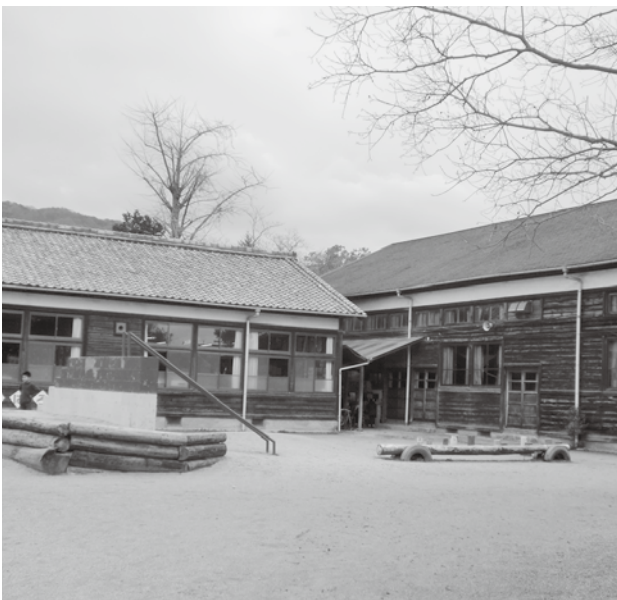
遅れる耐震補強工事（恭仁小学校）
