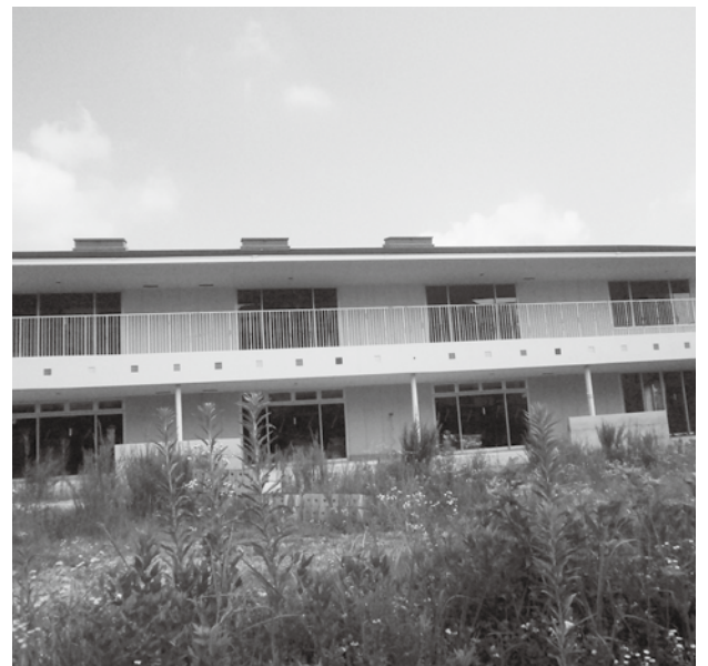
建設中断から約7年が経過した木津川台幼稚園
