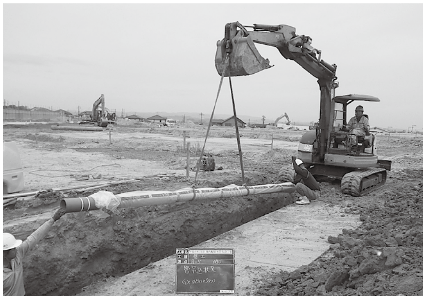
着々と進む水道管理設工事
