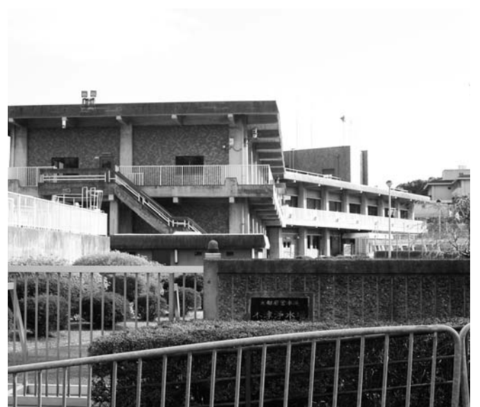
府営水道木津浄水場
