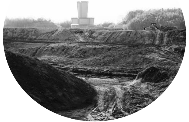
造成中の木津中央地区
