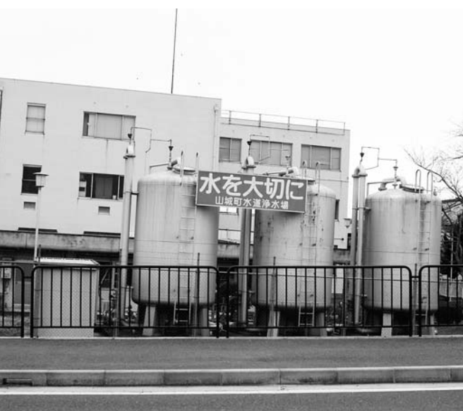
山城の浄水場
