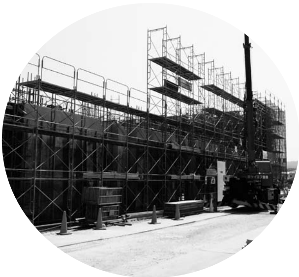
工事の進む (仮称) 学研中学校 (州見台)
