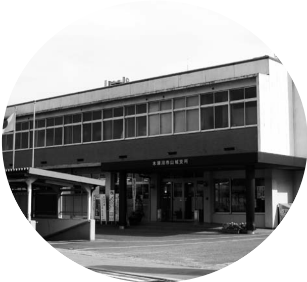
今年度中に改築工事に着手する山城支所
