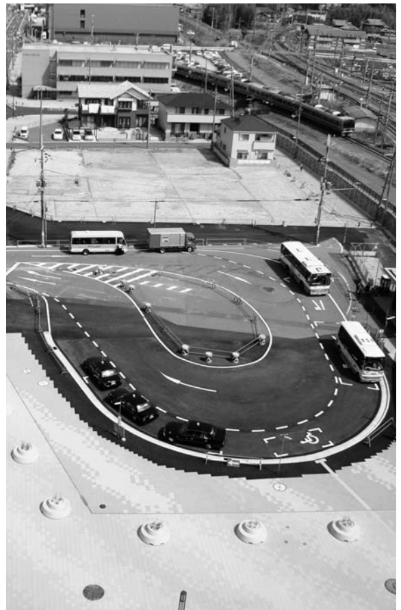
24年3月完成予定の木津駅前
