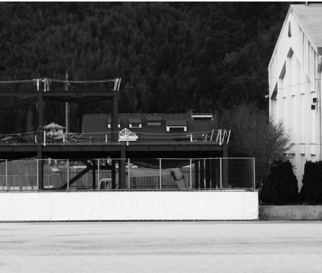
建設が進む給食センター
