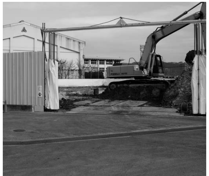
建設中の給食センター
