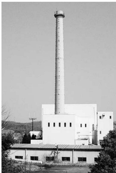
打越台環境センター
