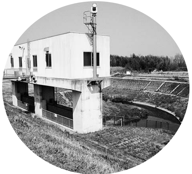
機能拡充が待たれる木津合同樋門
