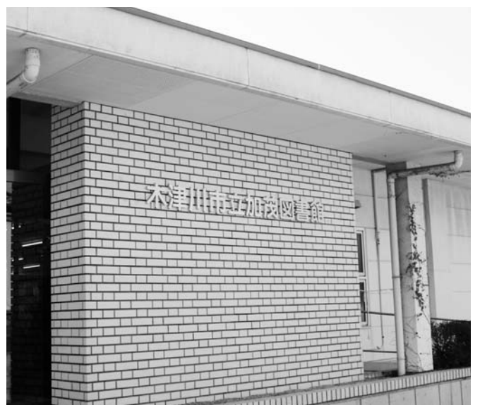
移設を待つ加茂図書館
