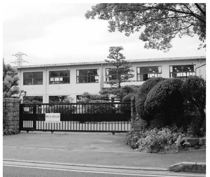
早急に耐震補強工事を（木津中学校）
