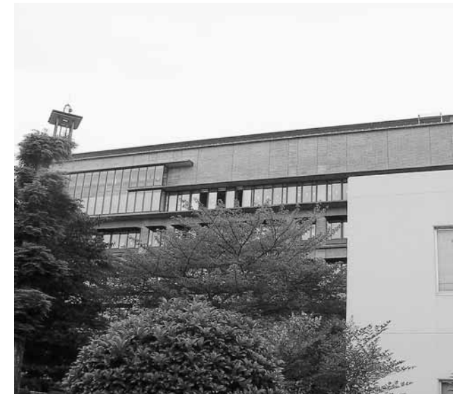
完成間近の新庁舎
