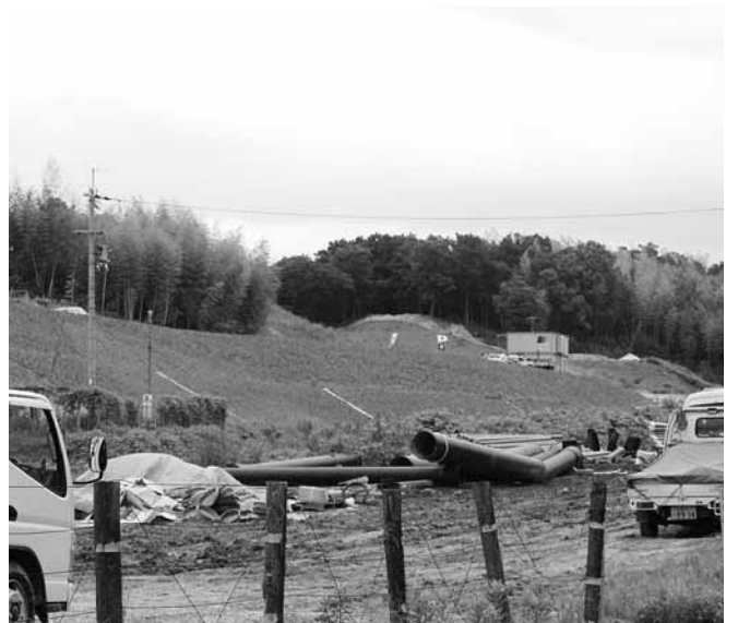
中央地区の配水池予定地
