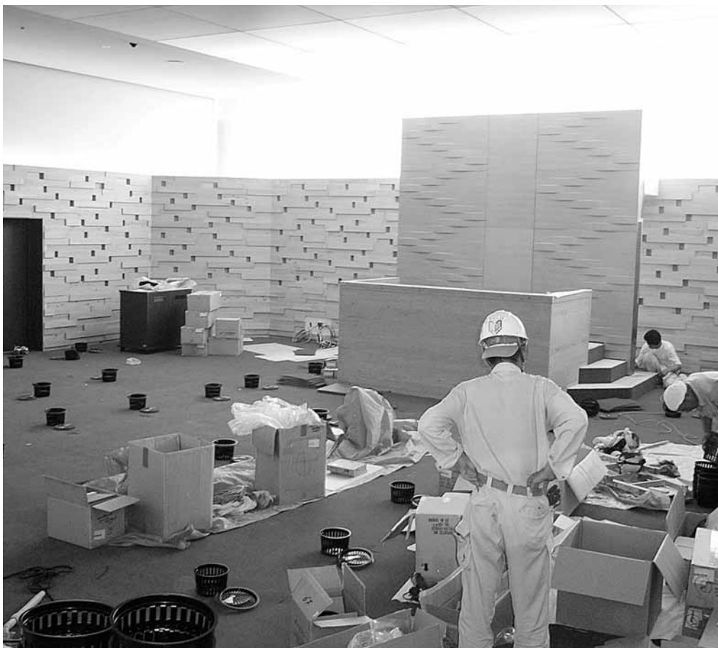
9月から議会は新庁舎で開催されます。（6階議場の内装工事）
