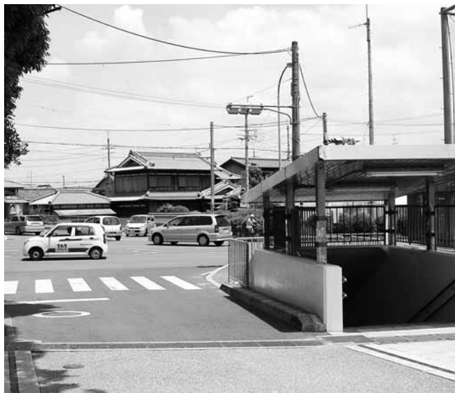
安全対策を（相楽小学校北側交差点・地下道）
