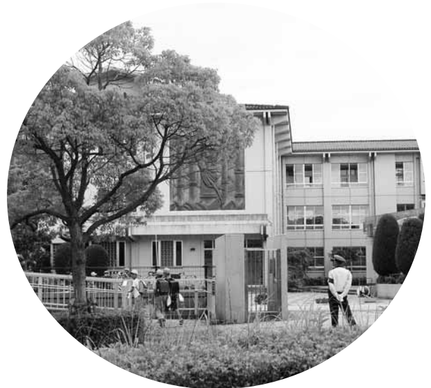
危惧される教室不足（木津川台小学校）
