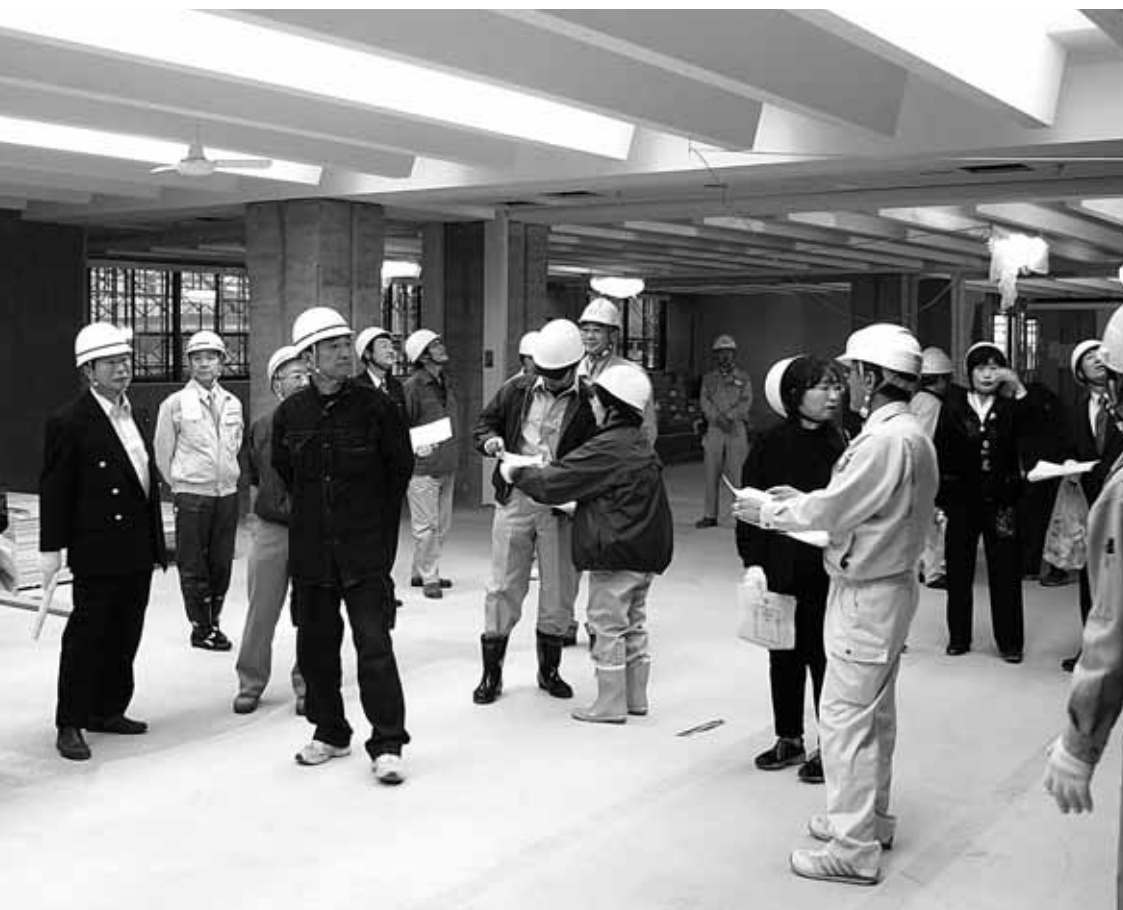
建設中の庁舎を議会で視察
