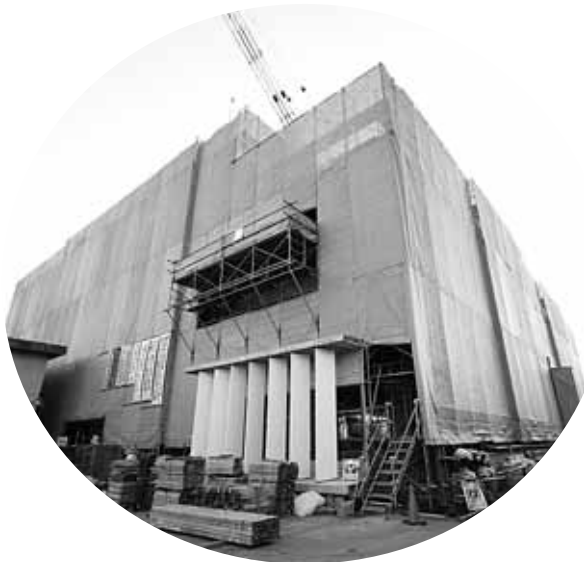
建設進む庁舎
