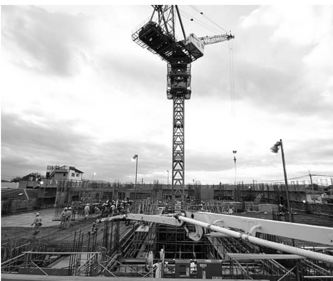
建設中の新庁舎
