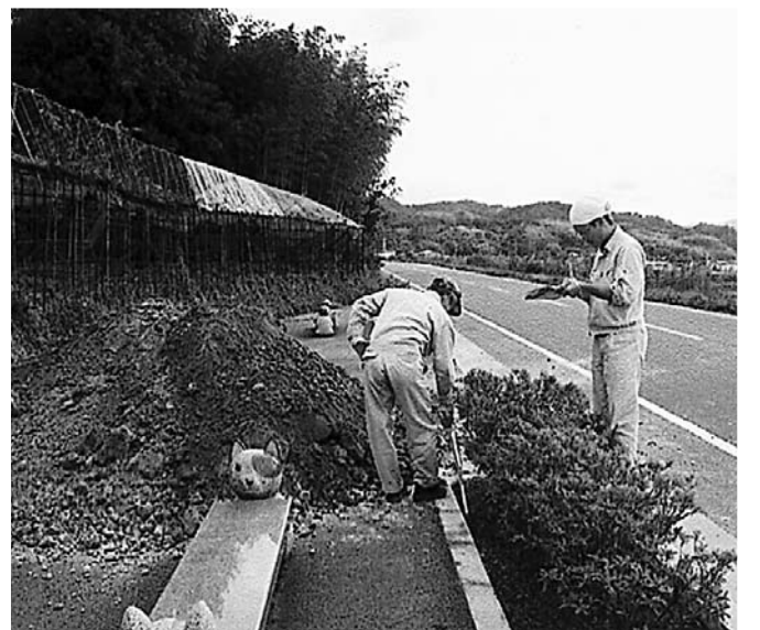
不法投棄があった現場（旧山城町）
