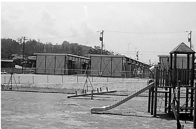
輪島市に設置された仮設住宅（200戸）
