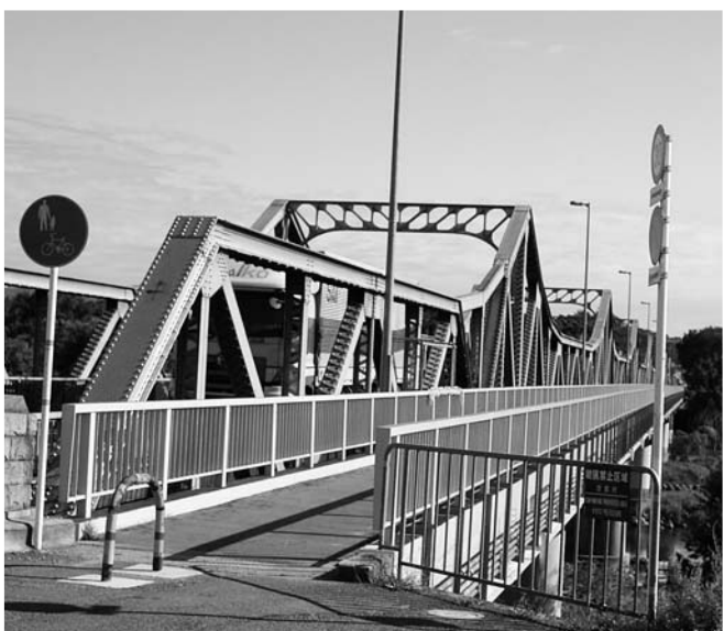
耐震補強された泉大橋
