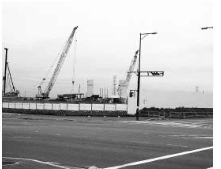
大型商業施設の建設始まる（州見台）
