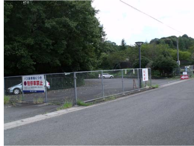
加茂プラネタリウム館駐車場全景
