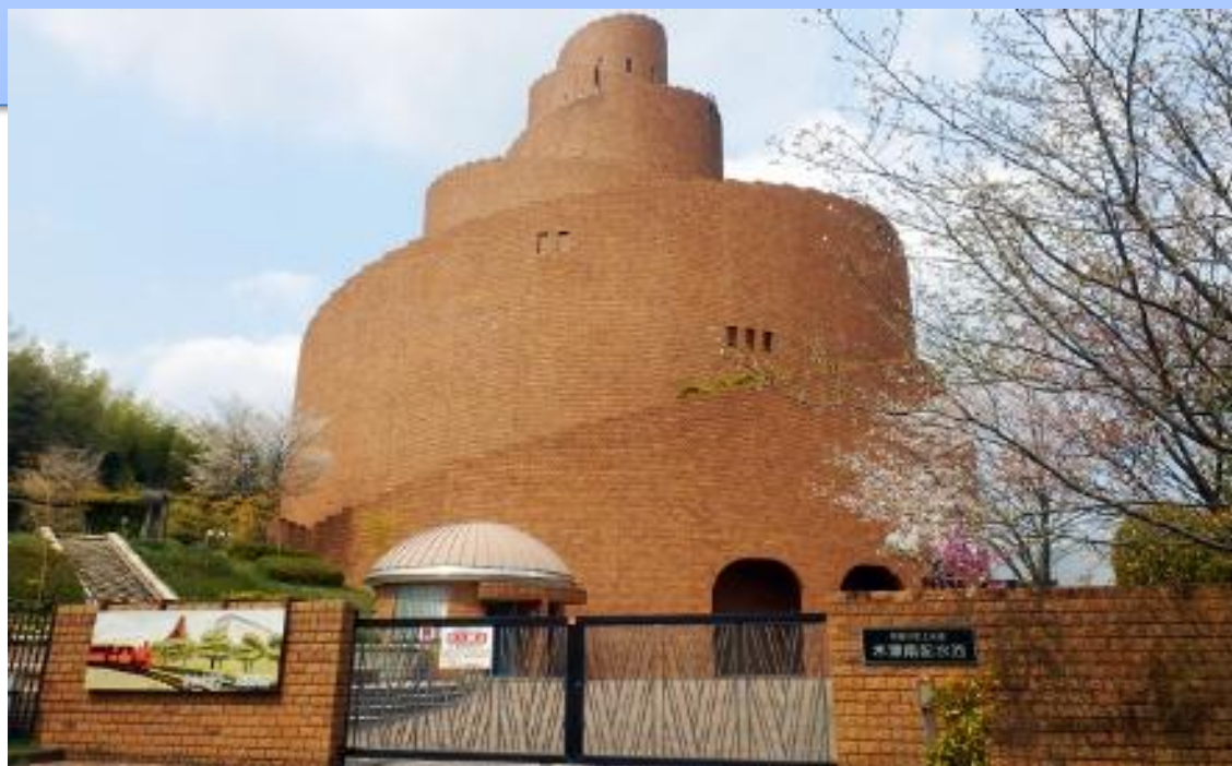
タツタタワー木津川市（木津南配水池）
