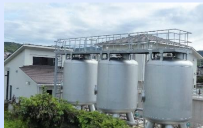
更新工事中の山城浄水場
