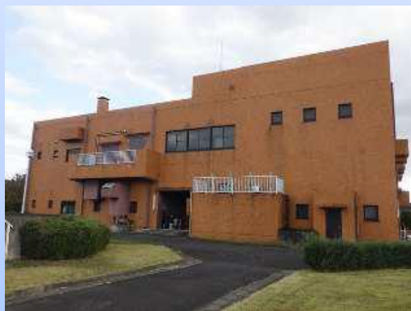
加茂浄化センター
