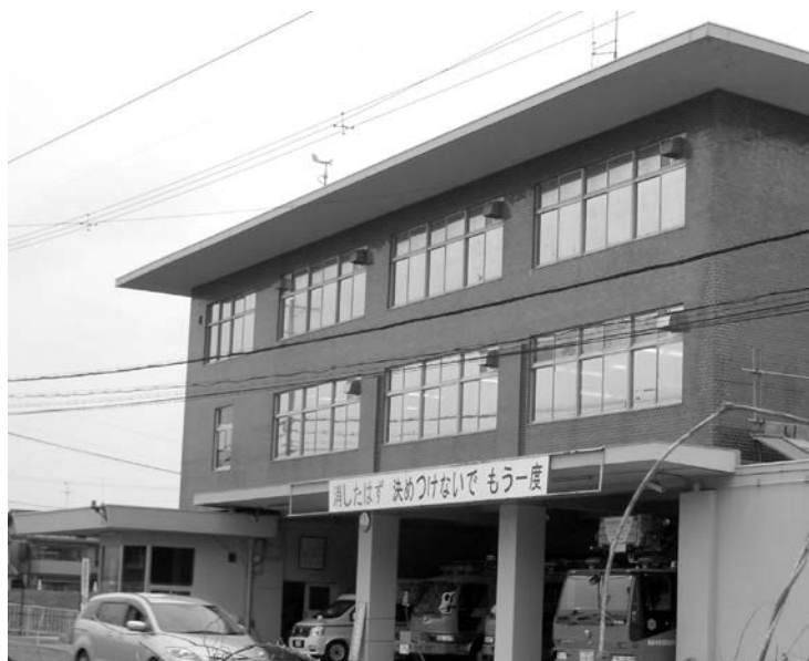
防災拠点として強化が望まれる相楽中部消防本部
