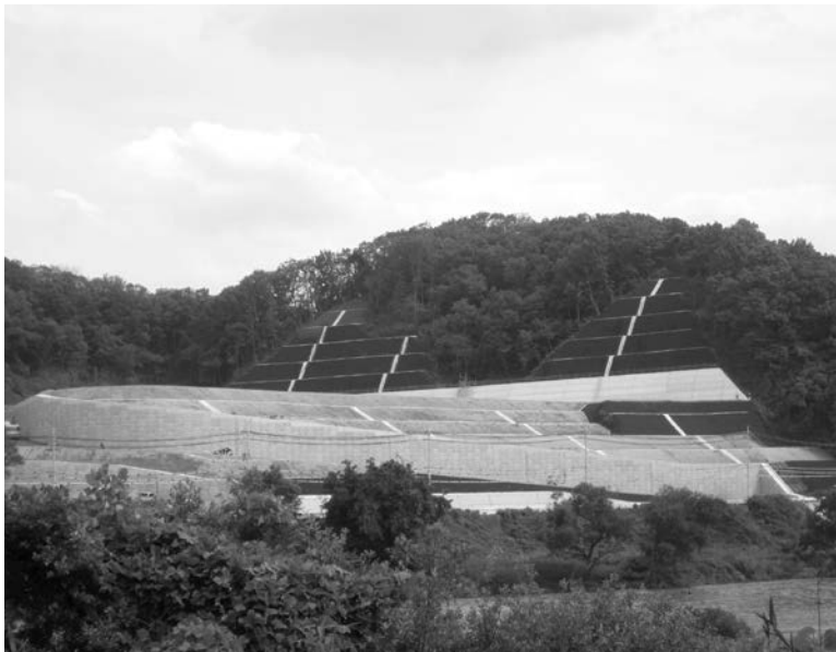
間もなく完成する敷地造成工事
