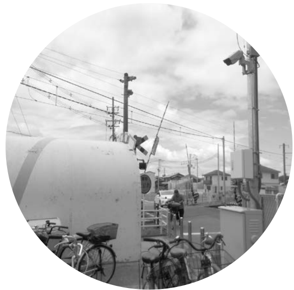
設置済の防犯カメラ (JR西木津駅駐輪場)
