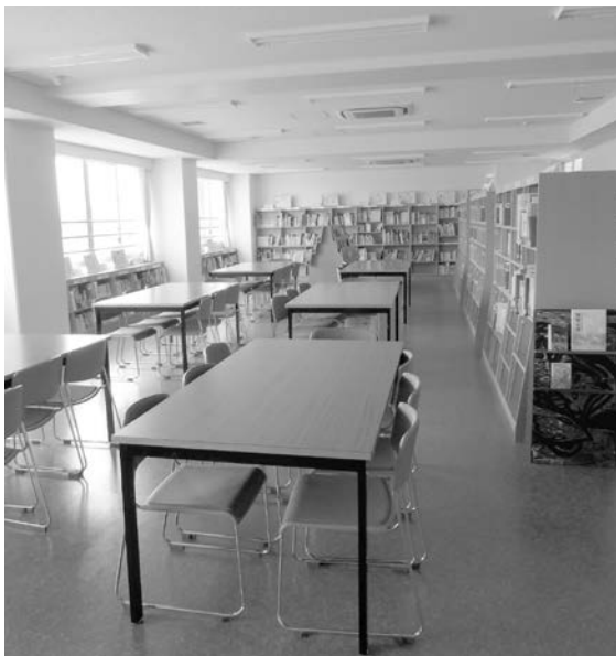
図書室に設置されているエアコン（木津中学校）
