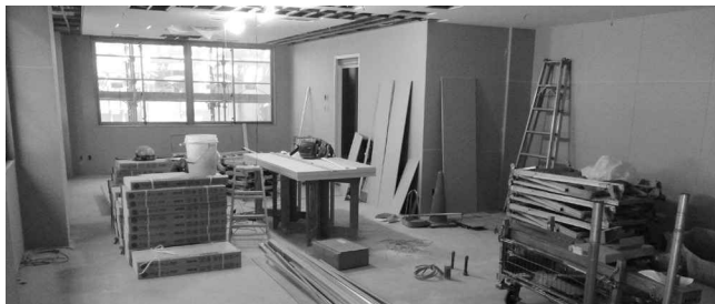
工事中の木津人権センター・木津児童館複合施設
