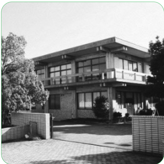
今後、更新工事が予定されている吐師受水場
