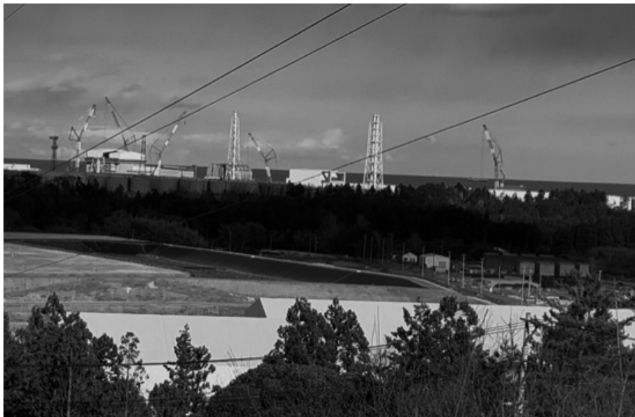
放射線量が高い帰還困難地域から見た工事中の福島第一原発
