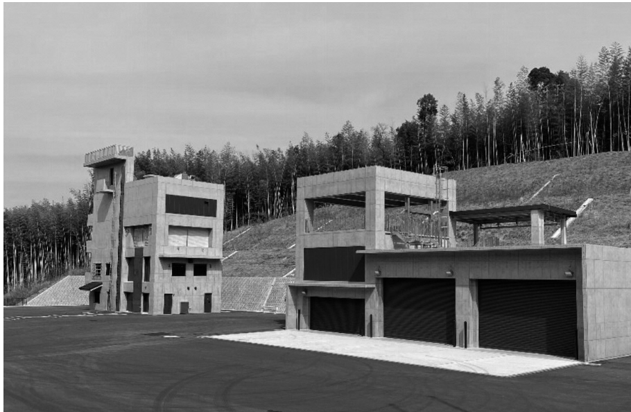
消防団や自主防災組織の訓練が可能となる相楽中部消防組合新消防庁舎訓練棟
