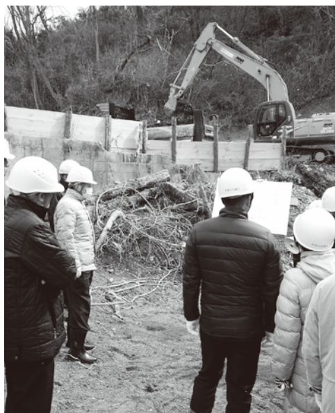
敷地造成工事の現地調査
