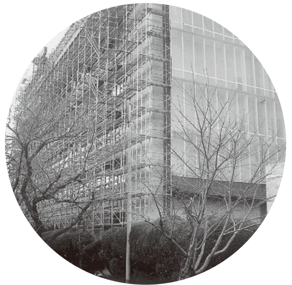
完成から4年余り、大規模な外壁補修工事が行われた本庁舎
